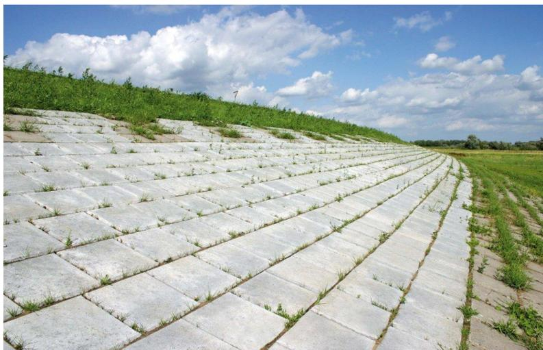
Abb. 3: Beginnende Begrünung eines Deckwerks ca. 1 Jahr nach Verlegung (Quelle: Berding-Beton GmbH)
