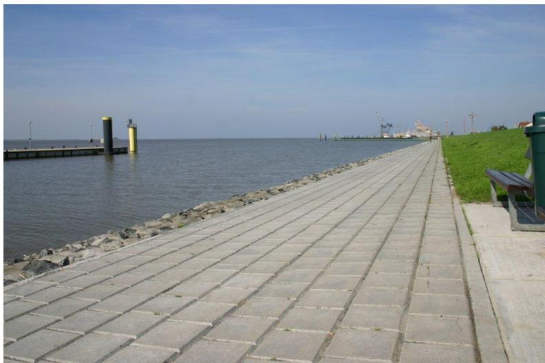
Abb. 2: Deckwerk aus verzahnten Setzsteinen (Quelle: Berding-Beton GmbH)
